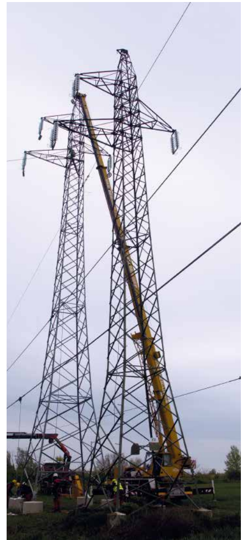
Nagyfeszültségű oszlop cseréje a 17-es vasútvonalon
