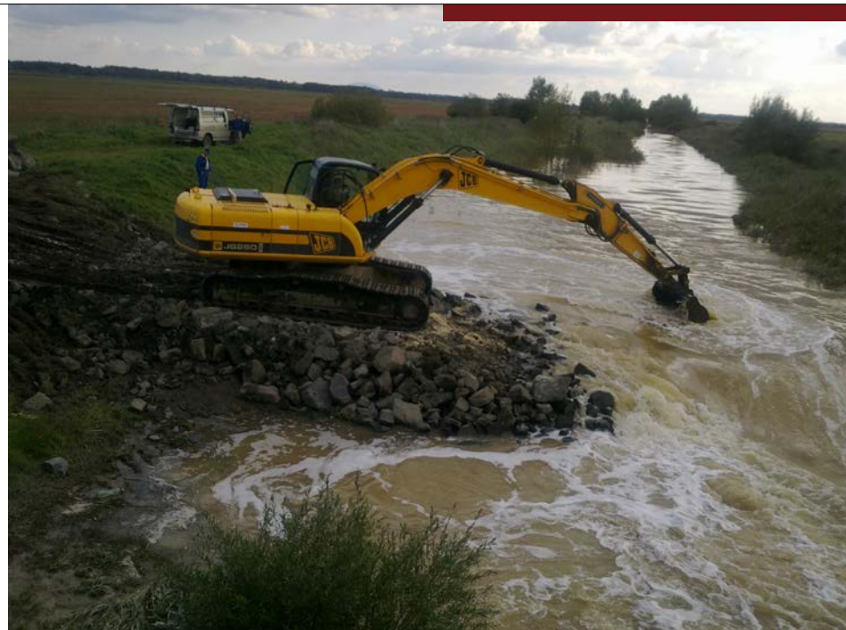
Gipszadagolás a Kemeneshőgyési ideiglenes duzzasztónál
